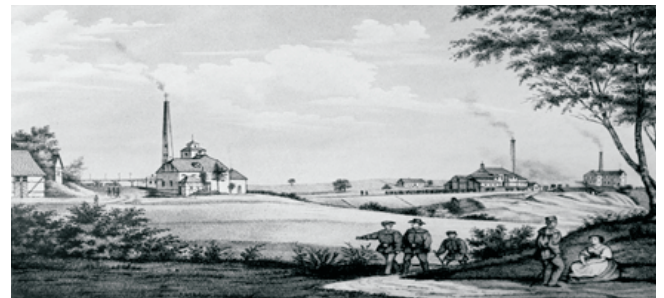
Ansicht der drei o.g. Schächte
