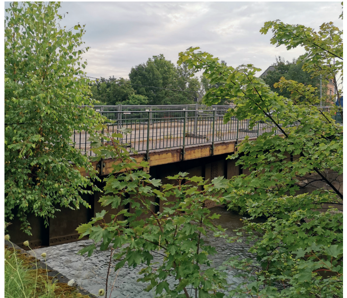
Die Cainsdorfer Brücke 2021, Foto C. Händel
